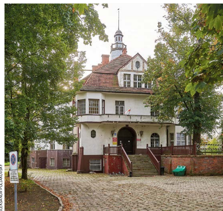
Zameczek z przyległościami jest wpisany do ewidencji zabytków
